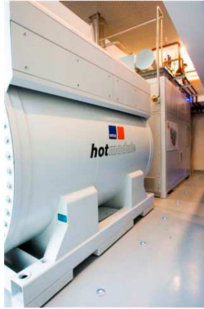
Figure 9 - La pile MTU CELLIA à l'OPAC de la Porte de Saint-Cloud (Paris)
