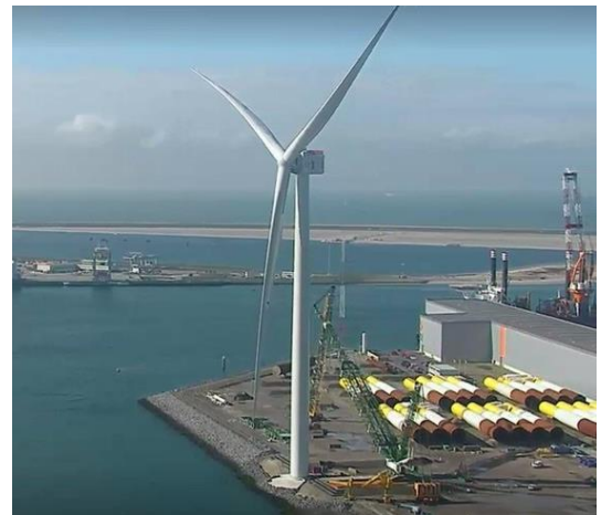
Figure 13 – Prototype de l'éolienne Haliade X dans le port de Rotterdam
