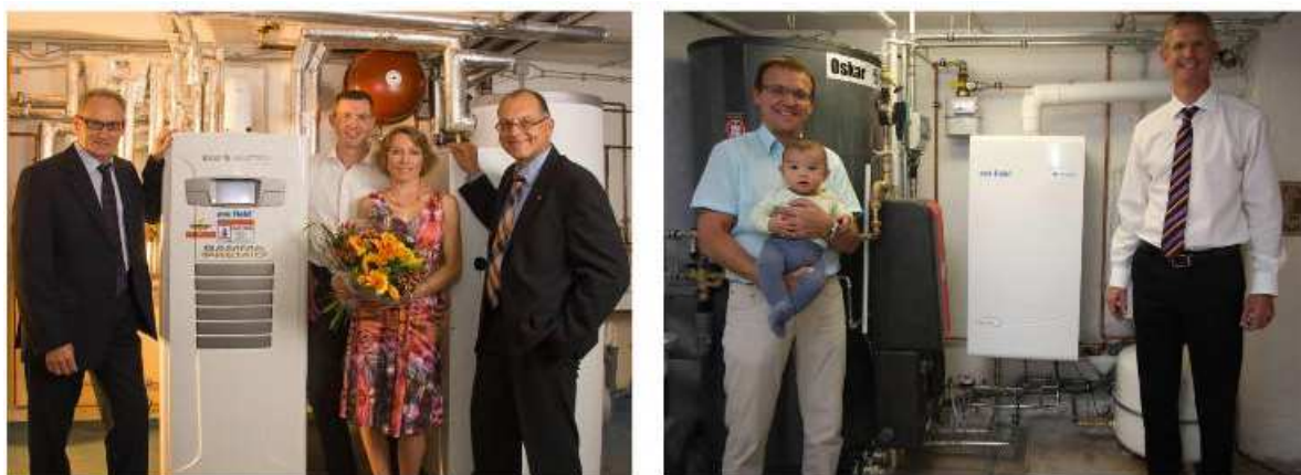
Figure 5 - Les deux premiers cogénérateurs Ene.field installés en 2013
