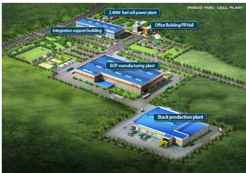
Figure 5 – L'usine de POSCO Energy achevée en avril 2011
