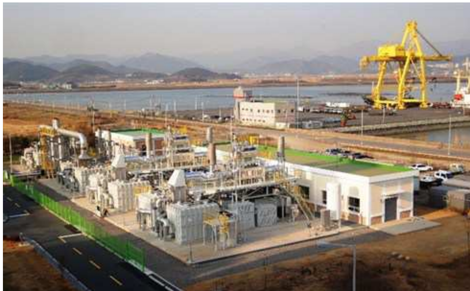
Figure 5 - La centrale de Bridgeport (14,9 MW)
