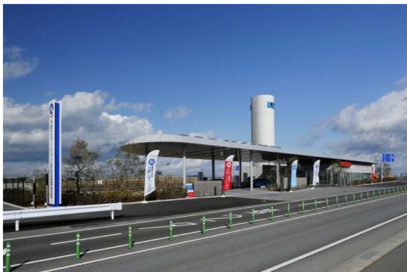
Figure 4 - La station de l'aéroport international de Kansai (Fév. 2016)
